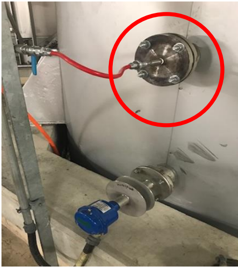
写真-5 フランジ常設
