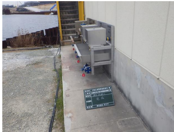
写真－5 薬品受入れ口整備状況
