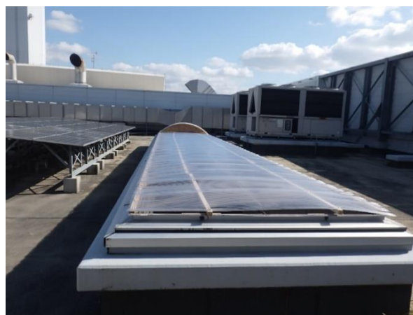
写真-10 トップライト仮復旧
