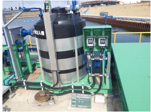
写真－4 チオ硫酸ソーダ注入槽整備状況
