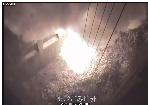
写真－1 ピット火災の様子1
