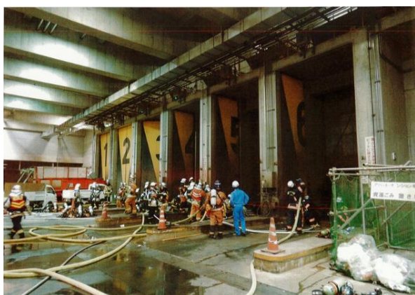
写真－3 消防隊による消火活動1
