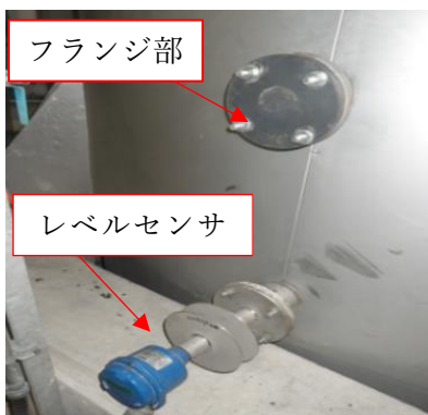
写真-2 フランジ部
