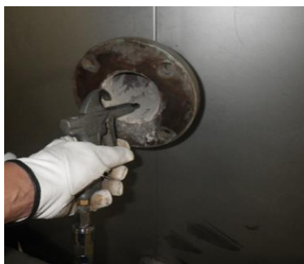
写真-3 エアレーション
