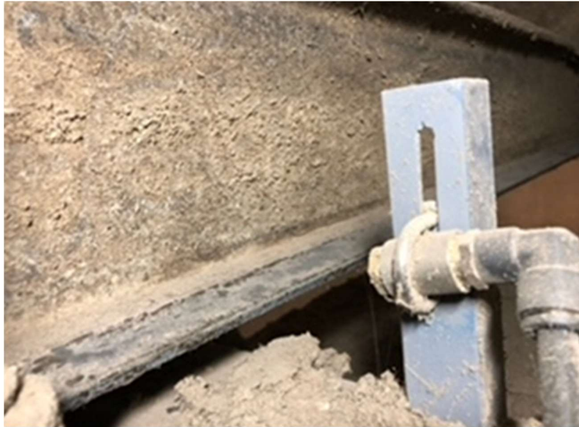
写真－9 高圧空気によってレール走行面の埃を除去
