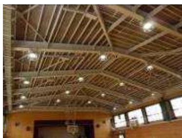
LED照明(港中学校:港区)
