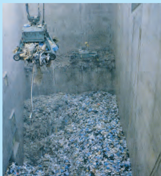
ごみピット・ごみクレーン…ごみピット容量約9,000m 3 、ごみクレーンつかみ量約2～3t
