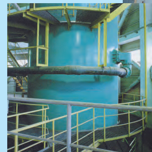
排ガス洗浄装置…排ガス中の塩化水素等を洗浄処理します。
