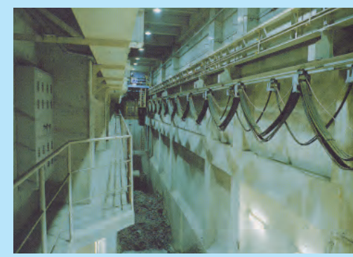
灰ピット…灰はごみのおよそ1/20以下の容積に、重量はおよそ1/5以下になります。
