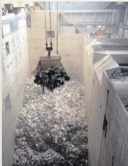
②ごみピット ④ごみクレーン ごみピット容量約11,000m 3 1回のごみクレーンつかみ量約4t A 4 ton crane grabs waste from a 11,000m 3 pit.
