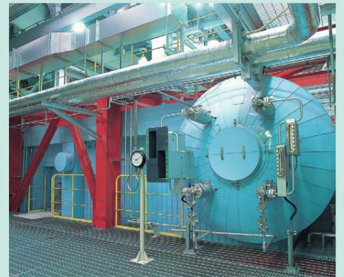
ボイラ 焼却熱を利用し、蒸気を発生させます。
