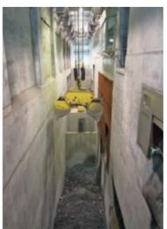
⑬ごみピット内の臭気を含んだ空気は⑭押込送風機で吸引し、⑮空気予熱器で加熱して、ごみの燃焼用空気として各火格子の下から焼却炉に供給します。
