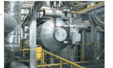
ボイラ 焼却熱を利用し、蒸気を発生させます。
