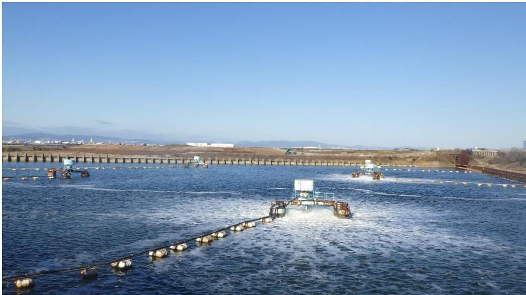
図 1 - 4 フローティングエアレータを用いた強制酸化の外観 (2017年1月撮影)
