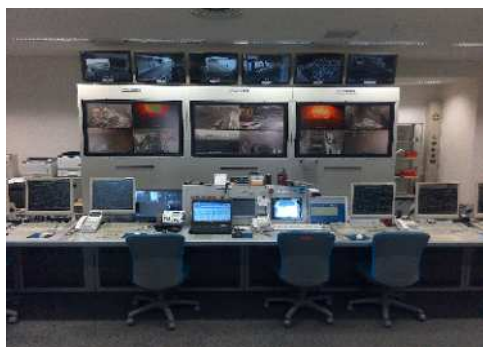
中央制御室 運転・監視
